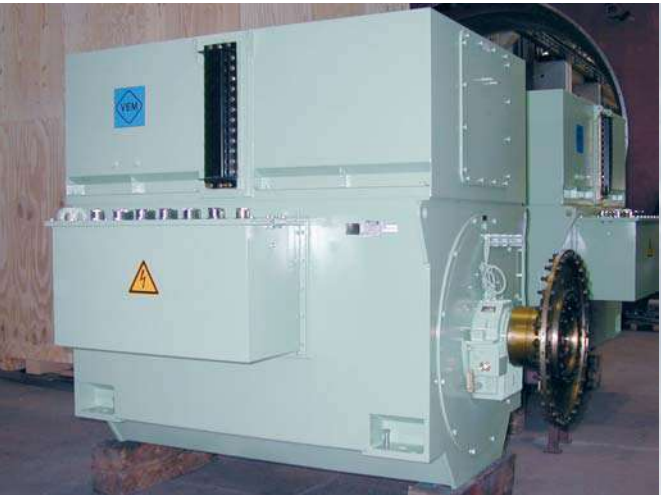
Проект “Maersk: Буксир для установки якорей” “Народная верфь” в Штральзунде/Германия РТО-генераторы (с механизмом отбора мощности) с последовательным расположением 2 x DRKSX 6321-4UA 2 x 3 250 кВА, 670 В, 1 800 мин -1 , IM 1101, IC 8A1W7
